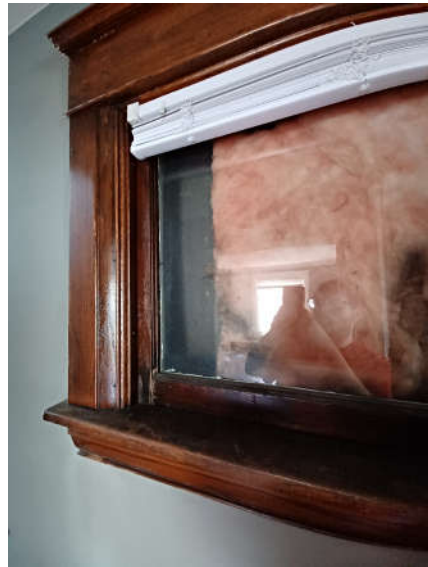
Stairs 7 Side D2 Window
